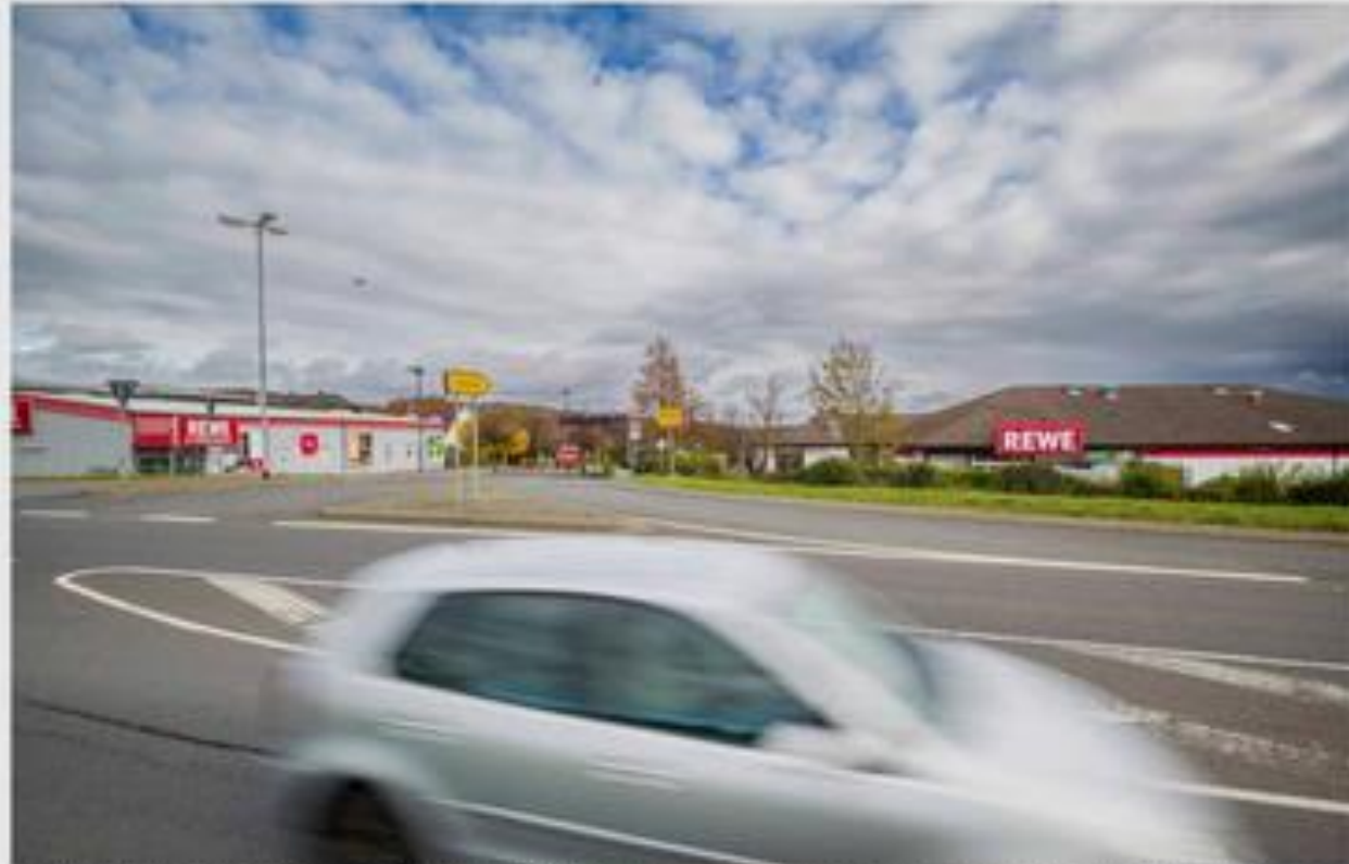
Der Glattbacher Rewe-Markt (rechts), der an der Staatsstraße 2309 in Richtung Johannesberg liegt, soll durch einen größeren und moderneren Neubau ersetzt werden. Der Getränkemarkt (links) soll ebenfalls dort integriert werden. Foto: Stefan Gröger
